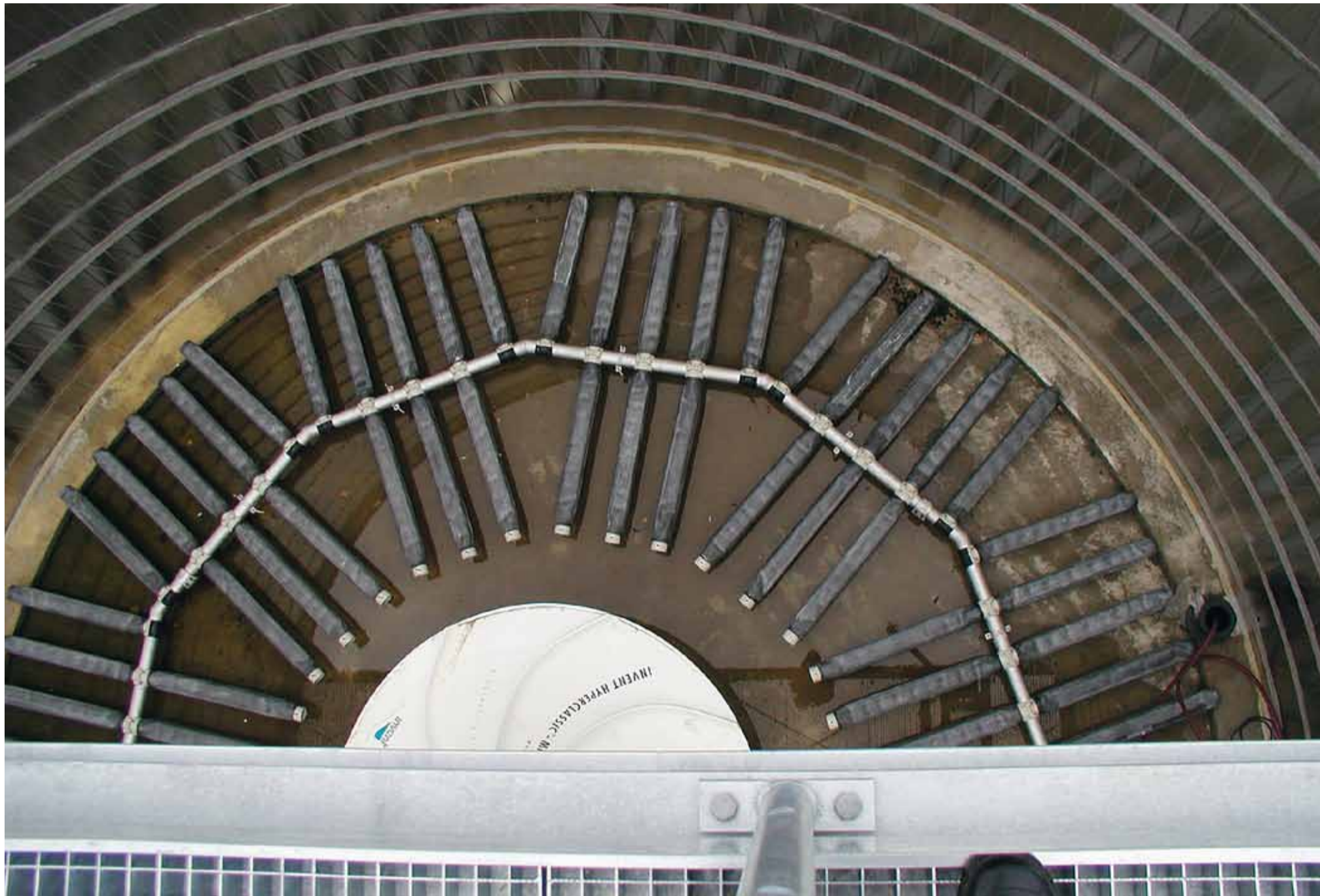
Belüftungssystem
