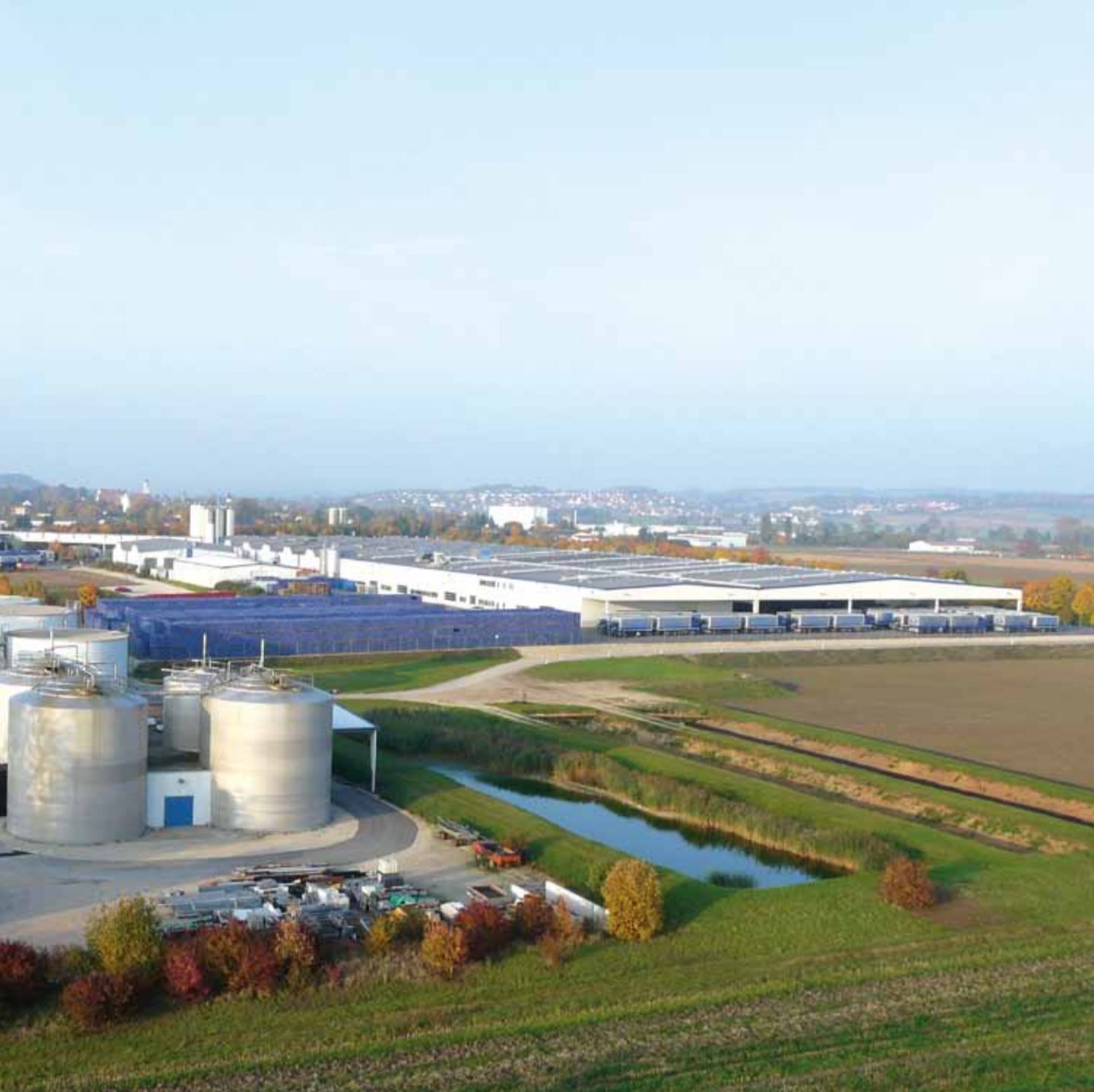
Abb 2: Betriebskläranlage Brauerei Oettingen
