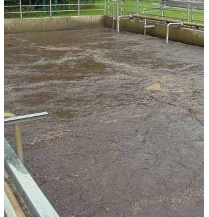
Gezielter Sauerstoffeintrag durch FU-Regelung der Gebläse
