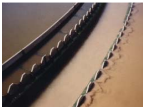
"anno 1985" massiver Schlammabtrieb im Nachklärbecken
