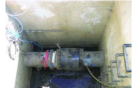
Applikation: Ersatz eines defekten MID
