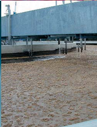
Schwimmschlamm/Schaum auf dem Nachklärbecken
