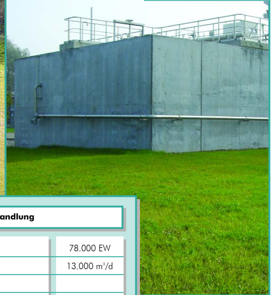
Gesamtansicht der Terra-N®/D Anlage
