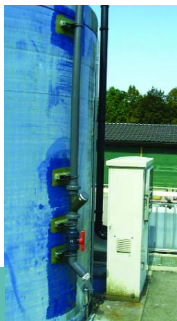
5 Neue Verrohrung (Befüllleitung, Schutzrohr mit Entnahme- und Bypassleitung) an einem GFK-Behälter
