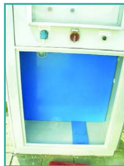
3 Der Neuaufbau der Dosiertechnik erfolgt hier auf einer Kunststoffmontageplatte. Notwendige Halterungen und Montagehilfen werden vor Ort geschweißt.
