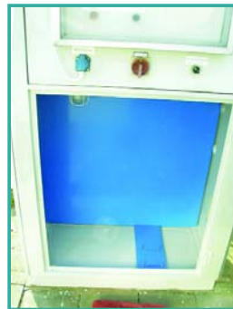
3 Der Neuaufbau der Dosiertechnik erfolgt hier auf einer Kunststoffmontageplatte. Notwendige Halterungen und Montagehilfen werden vor Ort geschweißt.
