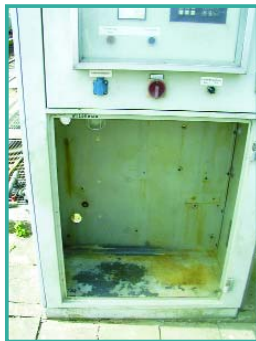
1 Nach der kompletten Demontage der vorhandenen Dosiertechnik werden die Einzelkomponenten gereinigt, geprüft und zur Wiederverwendung vorbereitet.
