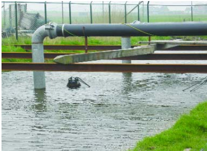
Bis zu 2.500 m 3 /h Wasser fließt von einem künstlichen Teich in die Pilotanlage
