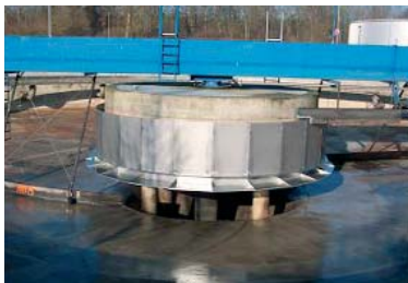
Bild 3: Foto der Zwischenklärung des Klärwerks Landshut mit umgebautem Einlaufbauwerk
